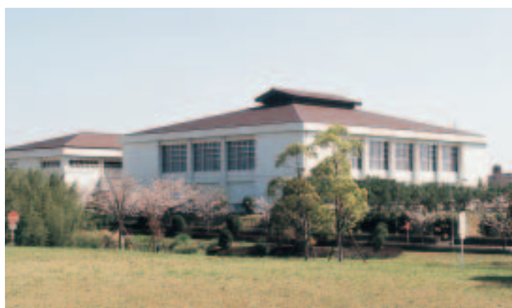
体育館 the Gymnasium
