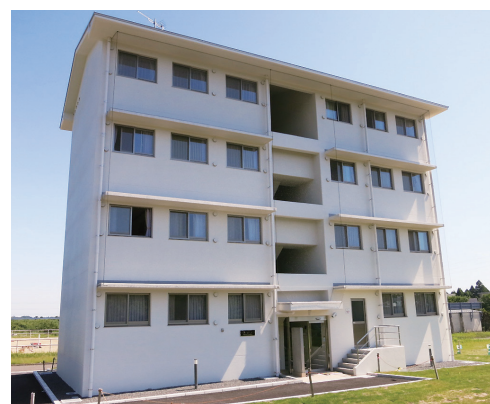
Kibana Dormitory 木花ドミトリー
