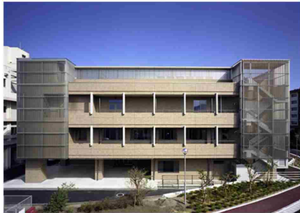
③中央診療棟 建築年：2007年 建築面積：1,942㎡ 延床面積：5,712㎡ 階数：地上3階 構造：鉄筋コンクリート造（防震構造）
