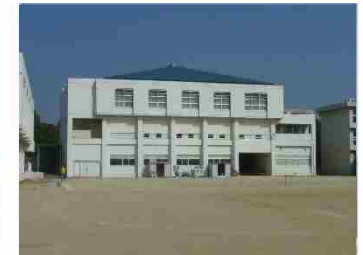
⑥附属中学校体育館 建築年：1996年 建築面積：1,219㎡ 延床面積：1,996㎡ 階数：地上2階 構造：鉄筋コンクリート造
