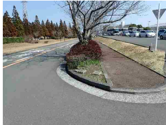
▲歩車分離された道路(速度抑制のためにハンプも設置)
