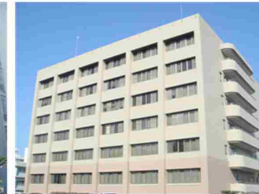
⑤総合教育研究棟 建築年：2003年、2004年 建築面積：1,899㎡ 延床面積：8,493㎡ 階数：地上7階 構造：鉄筋コンクリート造
