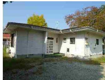
②木犀会館 建築年：1989年 建築面積：132㎡ 延床面積：132㎡ 階数：地上1階 構造：木造
