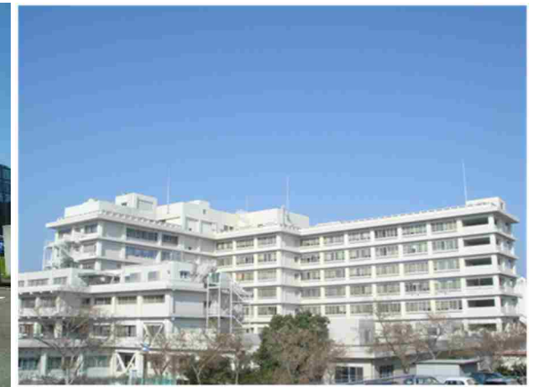
②附属病院（南側） 建築年：1977年（2013年改修完成）建築面積：12,344㎡ 延床面積：45,567㎡ 階数：地上7階 構造：鉄筋コンクリート造
