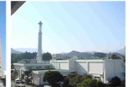
⑥中央機械室 建築年：1976年 建築面積：1,828㎡ 延床面積：1,860㎡ 階数：地上1階 構造：鉄筋コンクリート造
