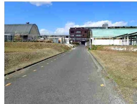
▲支線道路については歩道がない (区画線も消えている)
