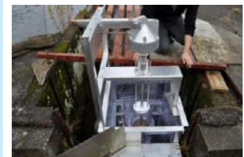
発電装置の設置風景
