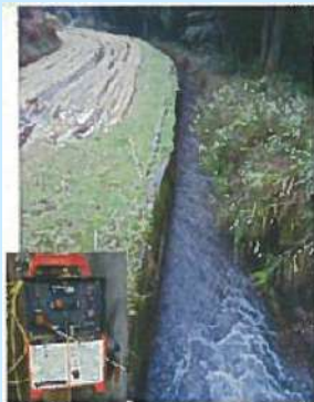
宮崎県五ヶ瀬町の水路
