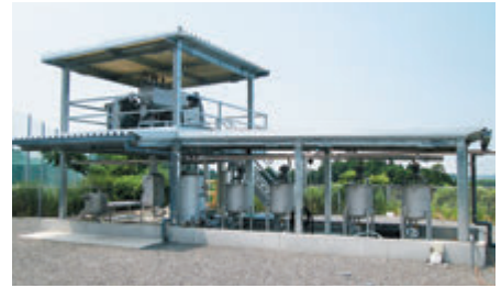
写真2 宮崎大学内 実証 パイロットプラント
