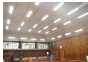
改修工事後の体育館と武道場
