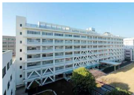
改修工事後の基礎臨床研究棟
