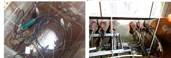
図 6-2-15. 台風等による屋外配電線の浸水被害
