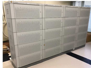
図 7-2-8. 老朽化した電話交換機設備 (電話交換機)
